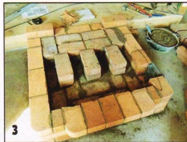
На третьем ряду кладки заложен дымоход печи, проходящий ниже пода камина.
