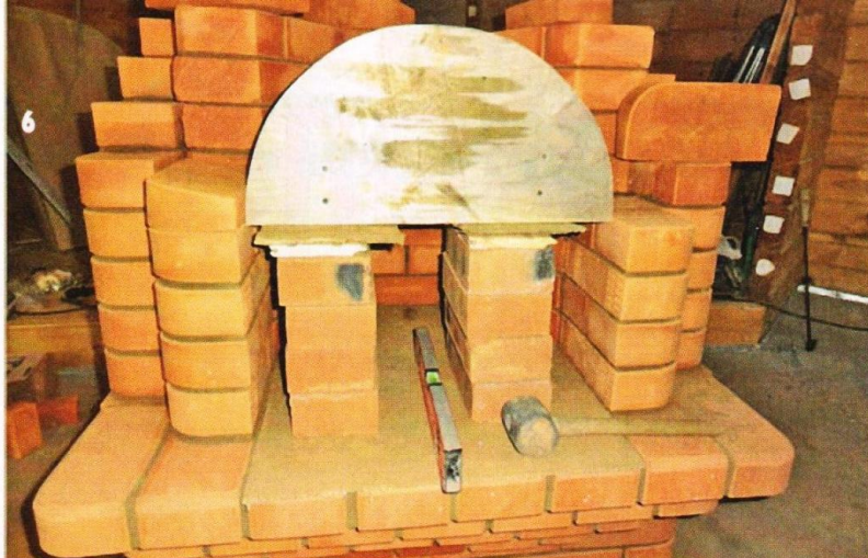
Для выкладки арки было изготовлено кружало, а кирпичи арки срезаны клином.
