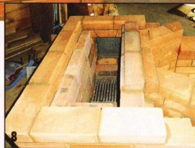
Для установки чугунного настила в кирпичах выбрана четверть.
