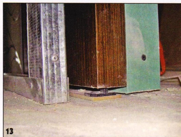
При навешивании двери П-образный профиль нужно надеть на фиксатор, установленный на полу.
