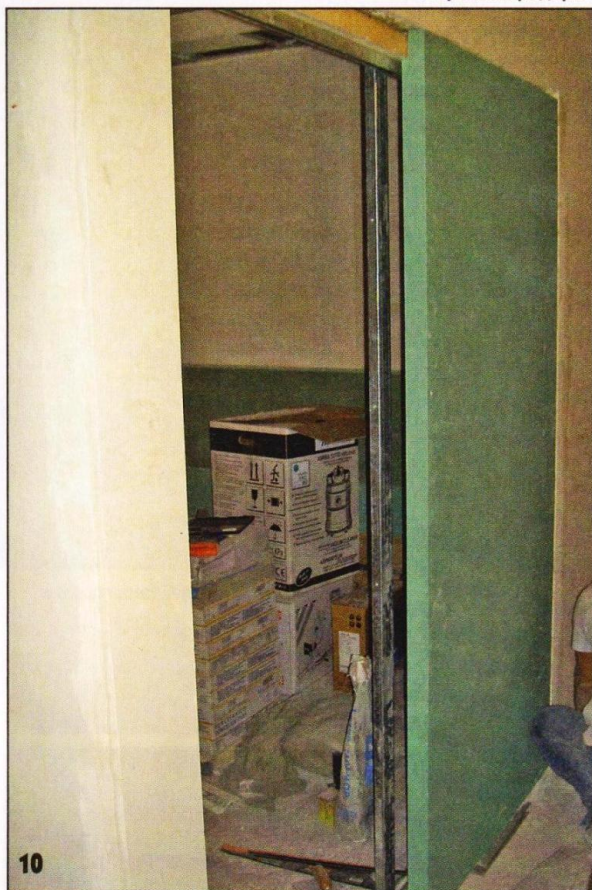
Каркас обшит гипсокартоном со стороны коридора.
