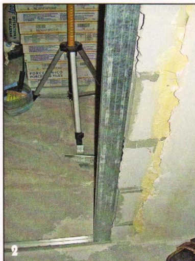
Стойка из сдвоенного профиля будет более надёжной опорой короба.
