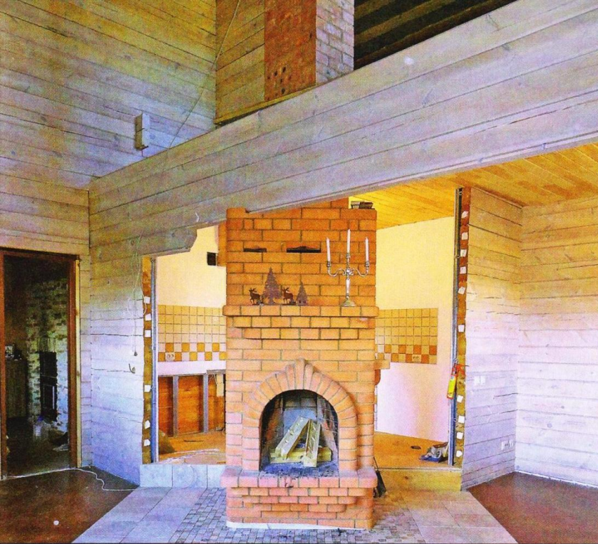
Печь ориентирована по диагонали, в связи с чем трубу на втором этаже пришлось развернуть на 45°.
