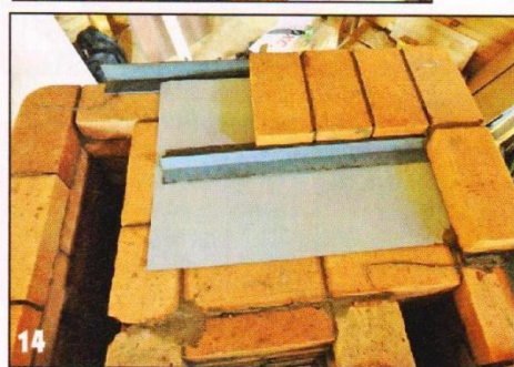
Последовательность операций при установке перекрытия варочной камеры.
