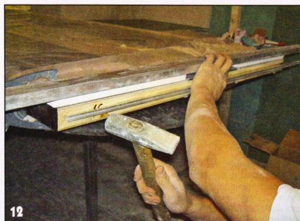
В канавку в нижней кромке дверного полотна вклеил на герметике П-образный профиль.
