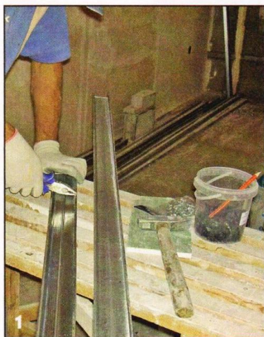
Чтобы соединить профили для стоек, предварительно нужно выпрямить загнутые края полок профилей.
