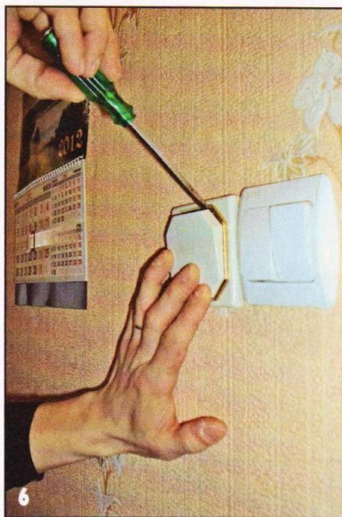
Поддев отверткой, снимают клавишу выключателя.
