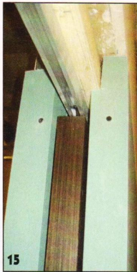
15 Короб полностью обшит гипсокартоном.
