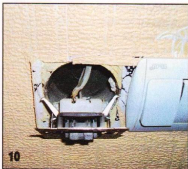
Теперь к колодке выключателя доступ обеспечен. По бокам колодки видны фиксирующие лапки.
